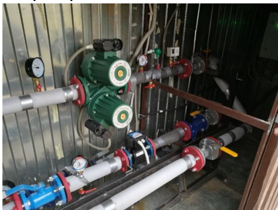
Установка автоматизированных тепловых пунктов
