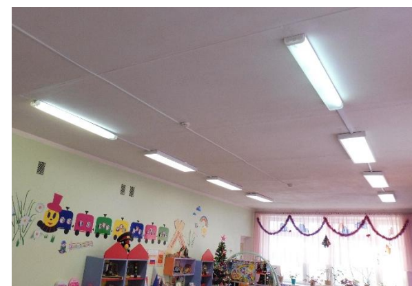
Замена светильников на светодиодные
