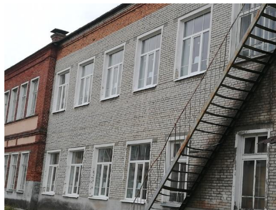
Замена оконных блоков на окна ПВХ
