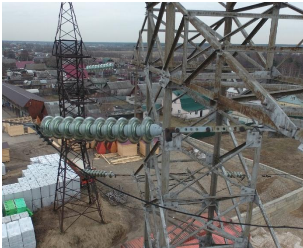
Контроль опор линии 110 кВ
